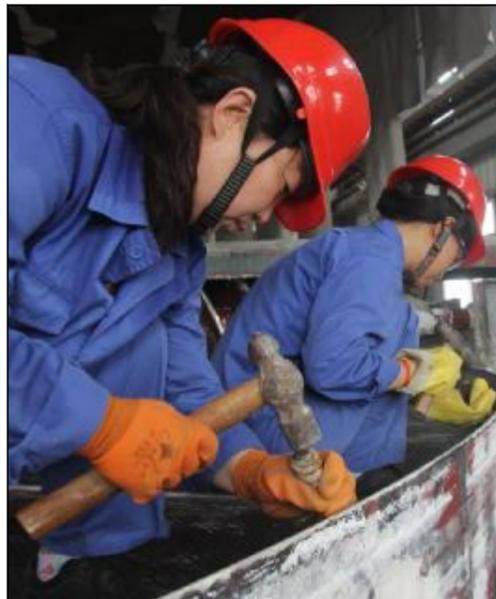
近日,第一氧化铝厂分解车间在2号平盘过滤机系统检修过程中,改进过滤布更换作业过程,有效延长滤布使用寿命。平盘过滤系统长期运行后,过滤效能低,洗涤效果差,车间成立了专业换布班,小到每一个压条沟内的清理,大到滤布的裁剪和铺设,都由专人指导操作,大大延长了滤布的使用周期,提高了平盘的运转率,节约了滤布费用。
