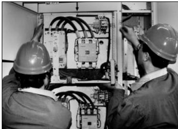
近日,80万吨氧化铝厂点检站电工一段组织电工对堆场BD-72A二段进行春检,一切安全措施到位后,有计划、有组织地对各电器元件进行了检查更换,为设备稳定运行打下了坚实的基础。图为点检站员工正在安装抽压柜。摄影报道 任卫红 王京民
