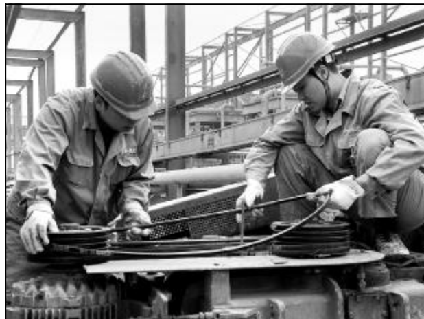
4月3日,氧化铝四分厂组织员工对拜尔法32台分槽电气、机械系统进行大规模的检查消缺。共检查清理滤油器30台、更换皮带10套、包扎处理电器接线盒及隐患问题32个。图为员工正在更换减速机皮带。摄影报道 赵萍
