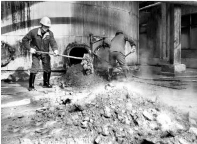
近日,为稳定高压溶出进料量,80万吨氧化铝厂二车间组织党员干部对原料磨2号料浆槽底部积料和槽壁结疤进行清理,大家克服天气寒冷和碱液、料浆不断溅出等困难,共清理积料约120m<sup>3</sup>。图为积料清理现场。摄影报道 任卫红 王玉红
