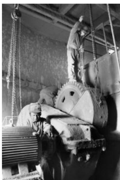
一月五日,检修分厂检修车间组织精兵强将,克服高空、灰尘等困难,发扬敢拼敢打的精神,经过三天顽强拼搏,顺利完成氧化铝二分厂四车间四十五度斜斗提升机的检修任务。图为参战员工分工解体减速机。
