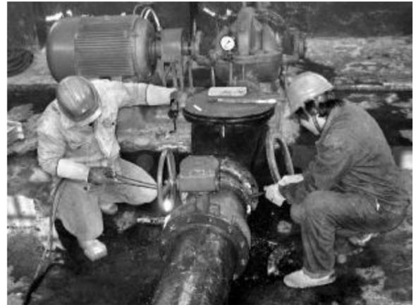
12月7日,为进一步优化水质,保证氧化铝空压站冷却水水质合格,水电分厂综合检修车间对空压站剩余4台水泵加装滤网。图为工人在改装、焊接阀门。摄影报道 王建军 张春萍
