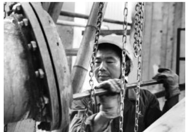
近日,80 万吨氧化铝厂五车间通过对母液槽出料管道的改造,有效地降低了种分母液中氢氧化铝浮游物的克数,减少了氢氧化铝的回头量。母液中的氢氧化铝浮游物由 7 月份月均 2g/l 降到了目前的 1.25g/l,经计算一年可减少氧化铝循环量约 4800 吨。图为检修人员在对母液槽出料管进行清理。
