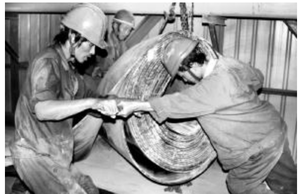
近日,80万吨氧化铝厂针对一车间进料皮带运行周期长、皮带老化等问题,进行系统消缺;同时,为保证稳定供料,点检站对7号、8号、9号、12号四条皮带进行检修,此次共更换皮带600余米。图为检修员工正更换8号皮带。摄影报道 韩宏建 任卫红
