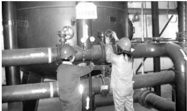
近日,热电厂化学车间为确保投资上千万的反渗透系统安全稳定运行,达到高产低耗效果,对高效过滤器进行全面清洗。清洗后,反渗透系统运行工况更优良,各项参数达到最佳状态。图为化学车间技术人员对高效过滤器进行化学清洗。摄影报道 胡俊岭
