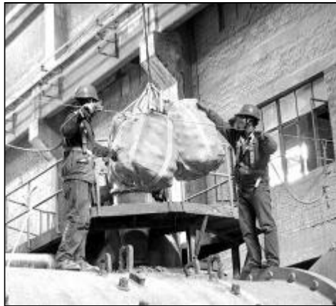
元月份,氧化铝一分厂矿制车间以提高原矿浆固含,60号细度为重点,加强设备维护,加强岗位操作,确保各项指标达到分公司要求。图为岗位员工定期给格子磨加补钢球。摄影报道 郭海斌 王颖
