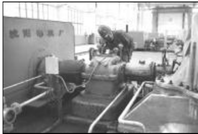
为进一步做好设备安全工作,煤气分厂对整管、洗涤塔、冷却塔风机加强日常点检与维修,岗位职工加大巡检力度,及时发现和处理设备运转中的新问题,确保设备安全稳定运行。图为职工正在巡检大型设备排送机。摄影报道 柴尚 郭长明
