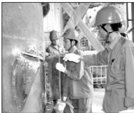
5月下旬以来，氧化铝四分厂掀起了“大干后10天完成月任务”的劳动热潮，生产全面进入高产期，拜尔法、烧结法三大分解率持续保持较高水平，4台焙烧炉稳定高产运行，5月22日，焙烧氧化铝5023吨，创出了今年以来最好的焙烧日生产率。图为焙烧一车间职工正在排除1号炉内衬脱落隐患。摄影 李亚峰
