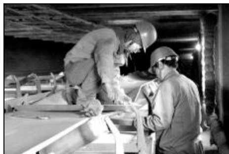
元月十三至十四日,氧化铝二分厂强化以点检为核心的设备维护模式,对翻车供料系统进行设备维护,确保各项生产任务的完成,为元月份生产开门红创造条件。图为员工们对皮带供料系统进行维护。摄影 靳雨
