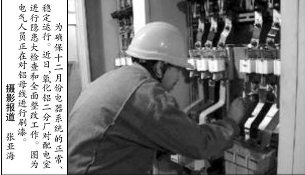
为确保十二月份电器系统的正常、稳定运行。近日,氧化铝一分厂对配电室进行隐患排查和全面整改工作。图为电气人员正在对铝母线进行刷漆。
