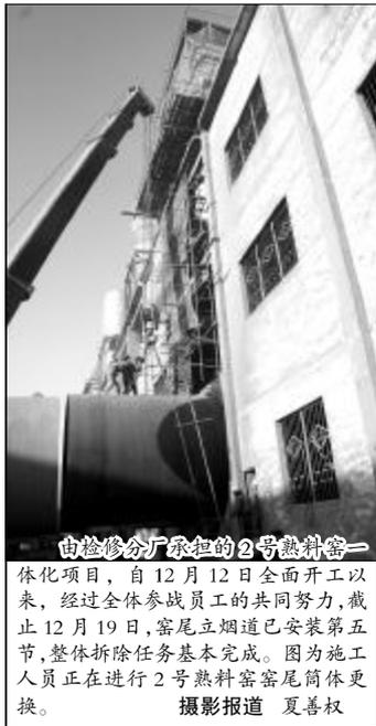
由检修分厂承担的2号熟料窑一体化项目,自12月12日全面开工以来,经过全体参战员工的共同努力,截止12月19日,窑尾立烟道已安装第五节,整体拆除任务基本完成。图为施工人员正在进行2号熟料窑窑尾筒体更换。
