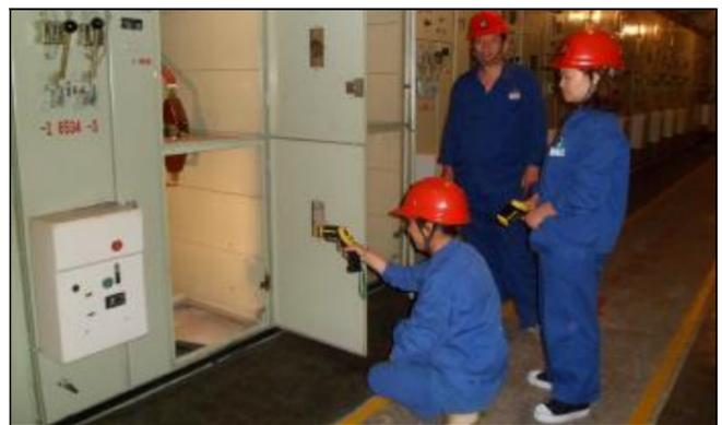
近日,水电分厂一车间在配电柜巡检中坚持开柜测温 and 夜间关灯检查,排查接点温度过高、设备放电等安全隐患,共发现处理发热点18处,事故隐患3处,为设备安全度夏发挥保障作用。图为车间值班人员正在测量配电柜温度。
