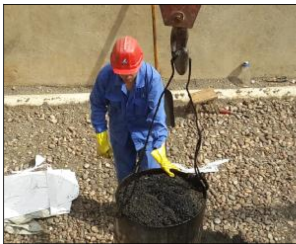
近日,受高温天气影响,水电分厂排水车间曝气生物滤池产生曝气不均匀,影响出水水质,分厂立即组织员工对曝气生物滤池进行清理,共更换150吨滤料、清洗回装1800个长柄滤头和曝气滤头,使出水水质各项指标恢复正常,达到可再生回用的要求。摄影报道 米增霞
