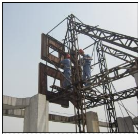
近日，生活服务中心维修二车间技术人员对发光字进行整体破损修复，技术人员克服高空作业，字体面积大、拆装难度高等不利因素，连续奋战一周完成维修任务，“晋铝现代”南北八个大字焕然一新，全部恢复明亮。图为维修人员正在修复LED灯。摄影报道 王海雷
