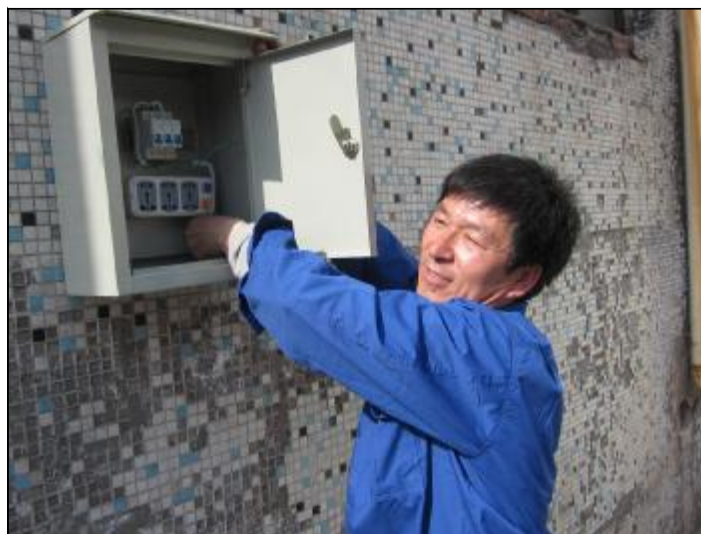
“这下,我们广场舞爱好者不再摸着黑跳舞了,你们用实际行动践行党的群众路线,真是社区服务的典范!”一位广场舞爱好者来到生活服务中心维修二车间感慨的说。今年以来,该车间以开展创建“模范车间”活动为契机,持续提升文明服务水平,深入服务一线为辖区居民提供便捷、优质的维修服务,千方百计为居民办实事、解难题,受到众多居民业主夸奖。图为车间技术人员在朝霞区活动广场安装电源箱。
