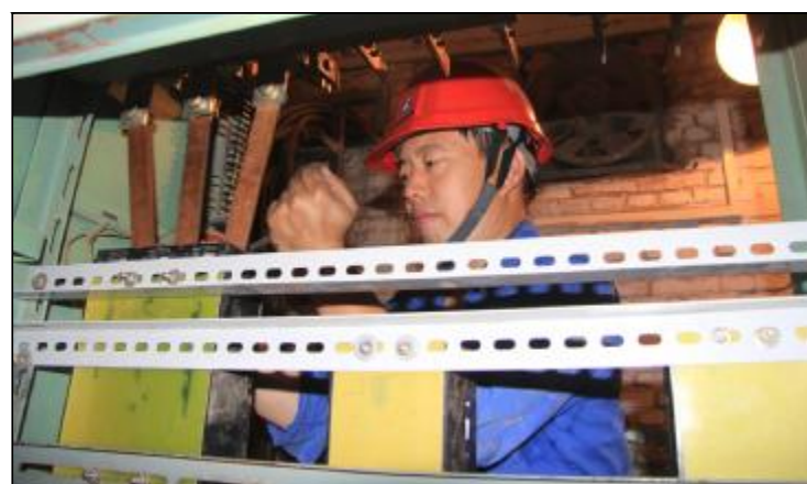
近日,第一氧化铝厂加强电气标准作业监管,严格遵守电气作业规程、执行电气“两票”工作制度,对两票的签发、作业现场确认以及“唱票”制度的执行情况实行专人监督管理,确保电气检修维护作业安全。图为烧成车间电工正在检修维护配电箱。摄影报道 张利 柴瑞红
