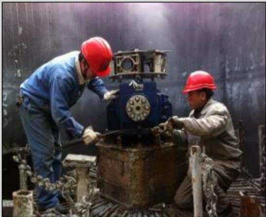
近日,水电分厂一车间对所辖区域十余台冷却塔进行全面检查,找平电机、紧固风叶、疏通油管、更换机油,检查消除降温设施,为夏季安全生产提供保障。图为检修人员正在更换 25D 冷却塔减速机。
