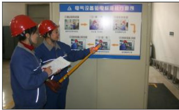
近日,水电二车间开展“标准化操作之星”评选活动,要求员工严格执行倒闸操作十大步骤,坚持操作预演、唱票、复诵等动作标准规范,活动开展以来,车间员工标准作业水平大幅提升。图为值班人员在目视化看板前模拟演练操作过程。摄影报道 薛秋云
