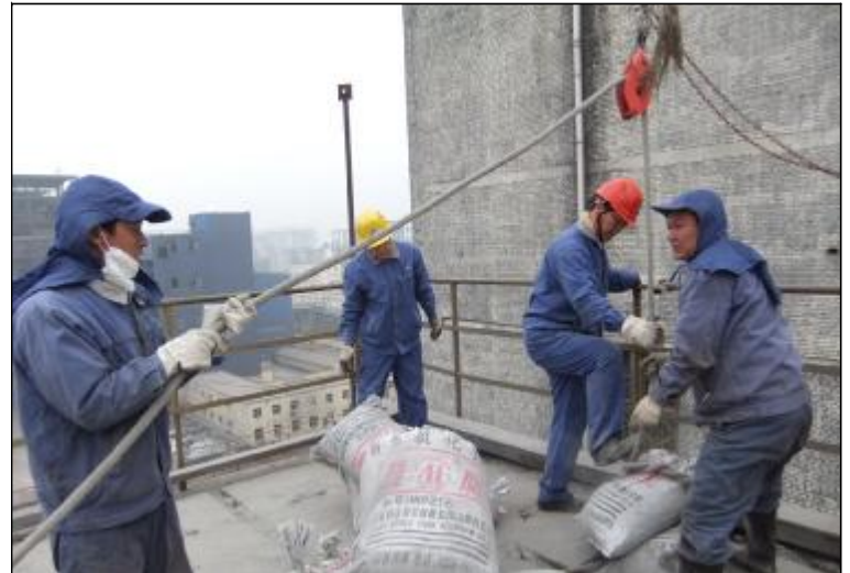
日前,热电分厂综合车间组织30余名检修人员清理运送锅炉炉灰。参战人员分为四个小组,利用滑轮、绳索等专用工具,对8号锅炉收尘5米、8米、15米和顶部平台等区域进行清理。他们克服天气寒冷、粉尘大等不利,将近280余袋炉灰清运至地面,使8号锅炉收尘环境卫生焕然一新。摄影报道 王军
