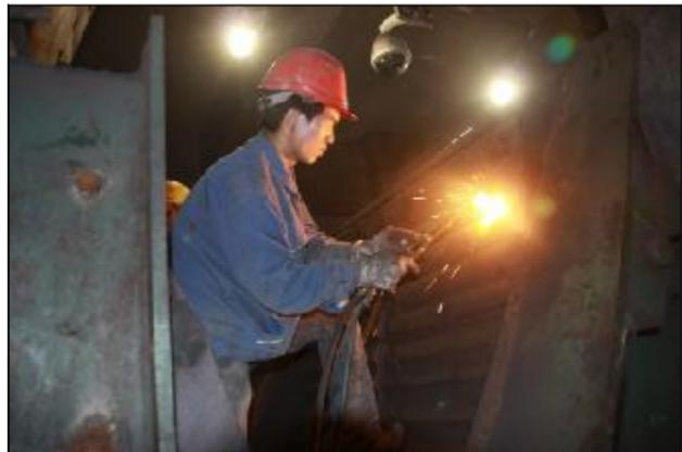
近日,热电厂燃料车间新系统输煤甲侧细碎机大修顺利完工,此次是该设备自投用以来第一次进行大修,主要包括齿板支架机构修复、更换齿板36块、锤头更换126个、料斗增加分流板等8个项目。大修完成后将进一步提升硫化床锅炉入炉煤的粒度合格率,使锅炉入炉煤10mm以上粒度含量降至3%以下,提高锅炉热效率。
