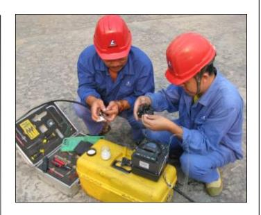
8月18日,石灰石矿电话线路发生故障,接到故障报告后,水电分厂三车间迅速组织人员进行勘察,确定为光缆故障。外线人员克服困难,顶着高温酷暑沿线徒步行走近2000米巡查断线点,对每一个有光缆接头和设备出口的地方进行检测,经过5个小时的排查,在对故障点进行重新熔接后,恢复了通信。图为检修人员进行仔细的光缆熔接。
