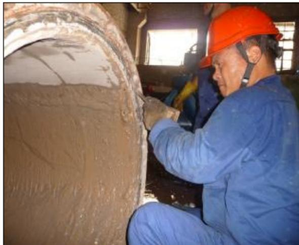
近日,水电分厂利用氧化铝停产机会对循环水泵房进行检修。检修现场,各车间、各工种交叉作业,检修人员克服高温酷暑等不利,经过5个半小时艰苦努力,顺利更换三个直径半米以上的阀门,为下一步安全生产打好了基础。图为检修员工在更换阀门前清理法兰结合面。
