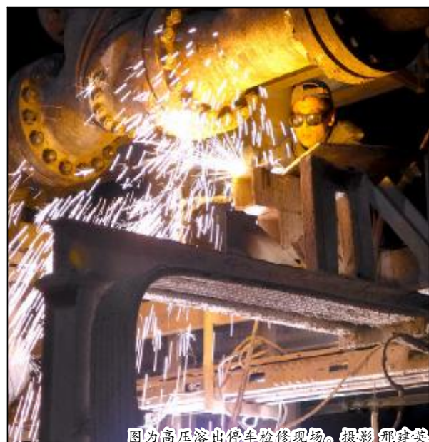
图为高压溶出停车检修现场。摄影 邢建英
