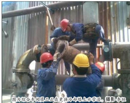
图为综合车间员工正在更换冷却塔上水管道。摄影李恒
