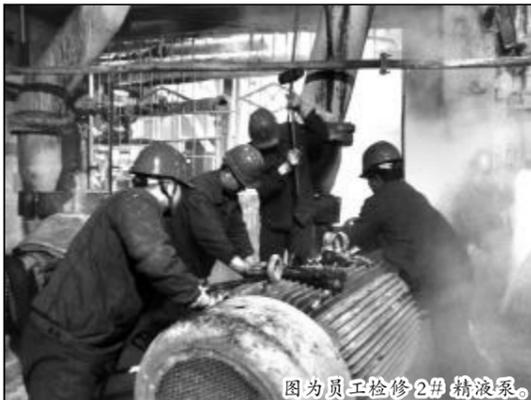
图为员工检修2#精液泵。
