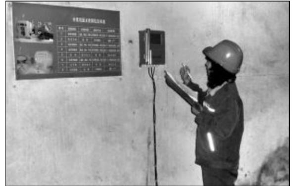
在开展运营转型工作中,水电分厂一车间认真调查分析循环水系统存在耗电高、运行不经济等问题,于12月初在厂南泵房进行改造试点,给烧冷1#、烧热9#加装流量计和累进器,要求岗位值班人员进行检测,每天定时统计数据,及时反馈给相关业务科室,为下一步安装变频器做好基础工作。摄影报道 郭翠萍
