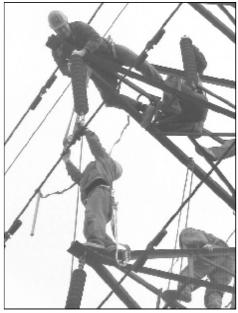
近日,水电分厂 对龙铝一回供电线 路进行了认真全面 的检查与维护。检修 队伍利用短暂时间, 对线路上近30米的 47 个铁塔及全线 5 公里线路进行了检 查维护,特别是对线 路上污染严重的合 成绝缘子全部进行 了更换,彻底消除了 线路隐患。龙铝线路 两回、渭南网线路一 回是山西企业主供 电线路, 担负着山西 企业的生产、生活用 电。图为检修人员正 在维护主供电线路。 摄影报道 王军 马俊琳
