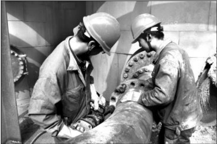
以人为本强素质,挖潜增效当先锋。近日,检修分厂大修厂把提升员工素质作为挖潜增效的突破口,在全车间内掀起了一场保安全、保质量、保工期、减少浪费、提升效率的挖潜增效高潮。图为检修分厂员工精心检修高压机。
