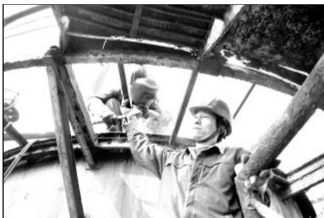
近日,热电分厂煤气板块综合车间对4台近25米高的洗涤塔安全隐患项目进行全面整治,通过采取加固、更换等方式,消除了洗涤塔上部三层平台及连接过道因腐蚀产生的安全隐患,为岗位人员日常操作提供了安全保障。摄影报道 杨红 王军
