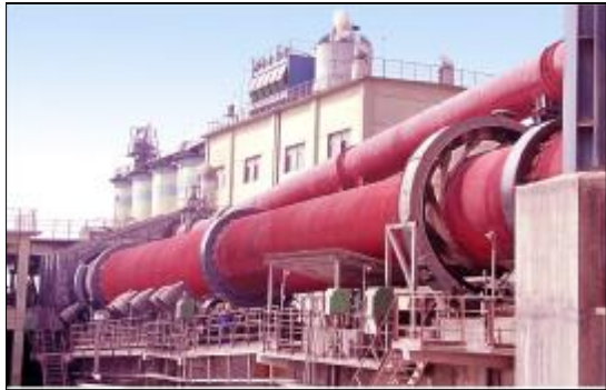
图为水泥厂生产现场。 摄影 曹红
