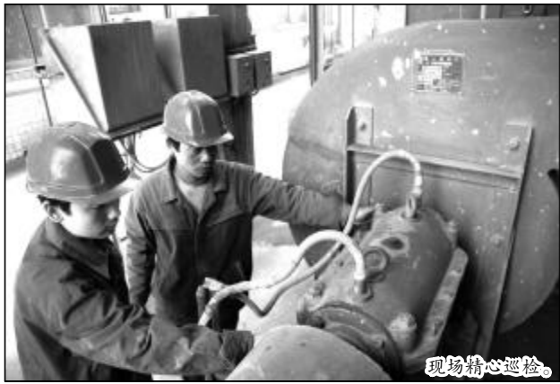
现场精心巡检。
