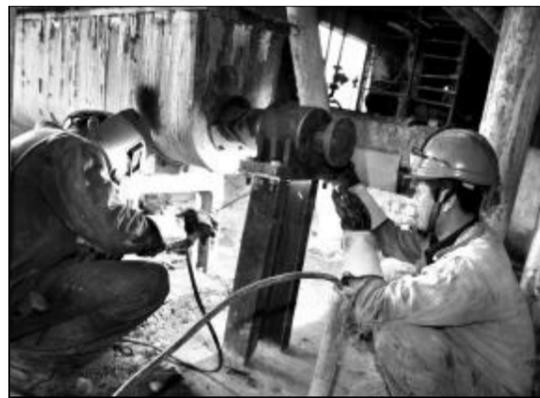
9月18日,检修分厂检修车间顺利完成第一氧化铝厂210G过滤器雾化器改造任务,提升了过滤器运行效率,进一步完善了氧化铝创新混联法,实现了节能降耗。图为检修员工在精心安装螺旋底座。
