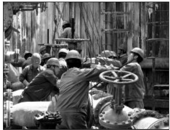
近日,在完成80万吨氧化铝厂沉降系统流程切换任务中,第二氧化铝厂综合一、二车间抽调30余人组成精干检修力量,提前进入现场,严格安全交底,连续奋战10小时,顺利完成检修任务。图为员工正在更换阀门。摄影报道 柴莉珍
