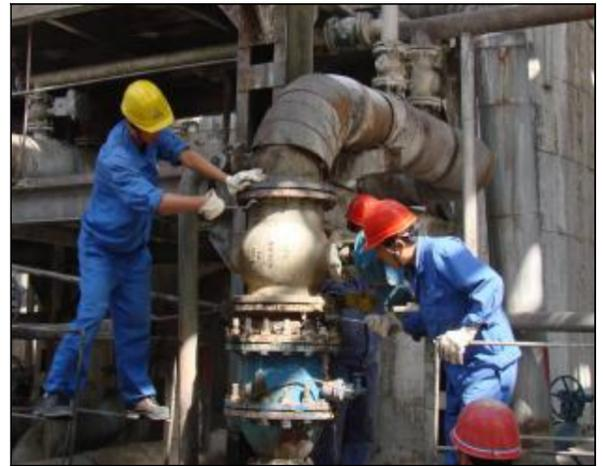
5月11日，第二氧化铝厂抓住高压溶出一系列停车的时机，组织检修人员对拜耳法种分系统进行消缺，于当日下午3时顺利完成全部消缺项目。图为检修员工正在更换母液泵阀门。摄影报道 张丽丽
