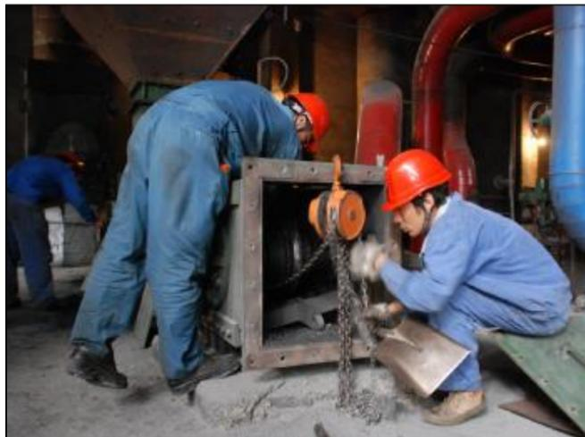
5月11日下午，热电厂8号锅炉乙侧给煤机链条突然断裂，影响锅炉稳定运行。接到检修任务后，检修三队迅速赶赴现场抢修，经过三个小时的紧张检修，给煤机恢复运行，保障了锅炉正常用煤。图为检修人员正在紧急抢修给煤机。摄影报道 陈文郁
