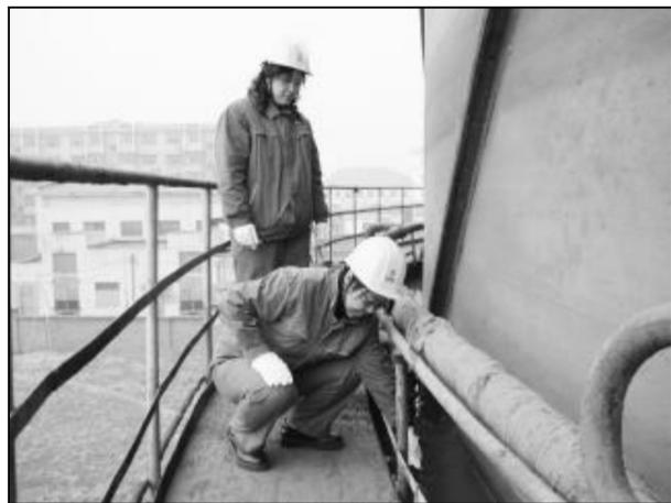
近日,生活服务中心民用煤气车间为确保冬季用气高峰期正常供气,加强了煤气气柜巡检,防止气柜水封结冰,并制定出煤气反事故抢修预案,确保居民生活用气正常。图为储气班员工在检查气柜水封。摄影 任福俊 王巧红
