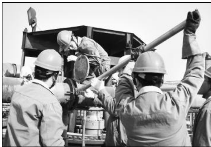
近日,煤气分厂对80万吨氧化铝进行检修对口支援,配合80万吨进行沉降槽组工作。图为检修人员正在倒组现场进行检修。摄影报道 金海波
