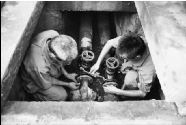
为确保今冬明春供暖工作正常运行,近日,东兴物业部维修中心组织人员,对辖区热网阀门、薄弱管道进行更换。现已更换热网进户阀门 58 个,更换工作正有条不紊地进行。图为维修中心员工正在更换管道进户阀门。摄影报道 王中生
