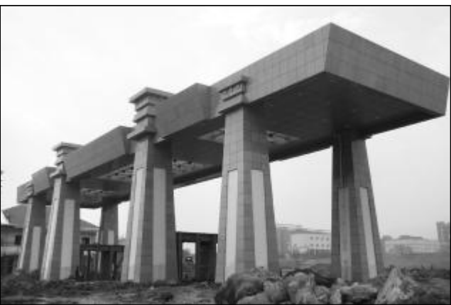
经过连日来的紧张施工,山西铝厂节能建筑环保建材产业基地大门结构外装修已基本完成,展露出其顶天立地、大气磅礴的勃勃雄姿,门前过往的行人和车辆无不向其行注目礼。目前,大门的地面处理仍在加紧施工中。摄影报道 本报记者 刘峰
