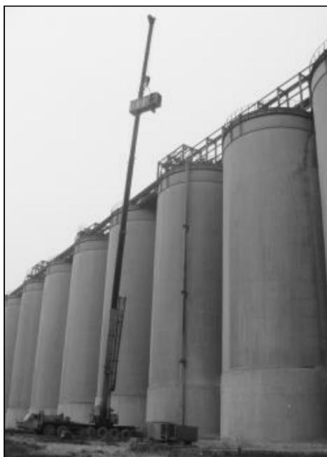
7月23日,检修分厂接到紧急更换空万吨氧化铝厂一步一号宽通道预热器任务后,针对吊装设备位置高、分量重的实际情况,积极制定稳妥的吊装方案,在10吨吊车的配合下,顺利完成了预热器的拆除、更换、吊装任务。图为吊车将重达18吨的旧预热器吊离20米高的种分槽顶部。摄影报道 张安泽 宁芬斌
