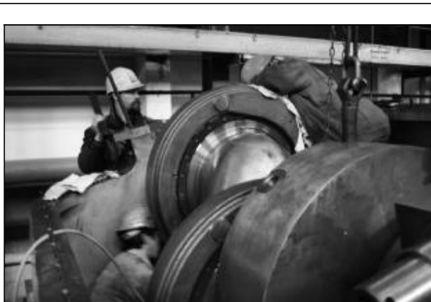
1月17日，山西分公司首次对80万吨氧化铝厂8台荷兰泵动力轴承进行系统检修，检修分厂检修车间承担了主要任务，目前已完成5台泵的检修，为分公司顺利实施023弹性生产组织方案创造了条件。图为检修人员与外国专家正对荷兰泵实施逐一检修。摄影报道 杨陆平 张安泽
