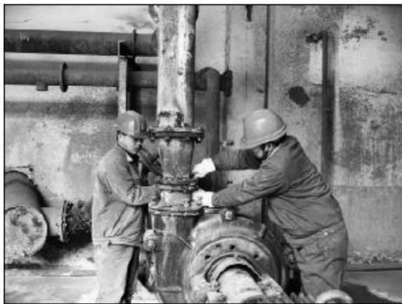
春节期间，氧化铝二分厂洗涤车间以强化责任心为抓手，要求岗位员工加强巡检，精心维护设备，为企业“挖潜增效、控亏增盈”和实现元月生产开门红做出更大贡献。图为岗位员工正在更换底流泵垫子。摄影报道 张灵霞
