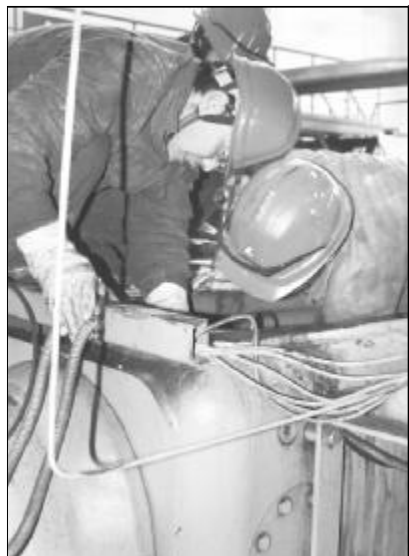
近日,20万吨氧化铝厂三车间对主体设备隔膜泵电机进行解体保养,主要内容为:电机内部润滑油更换、轴承间隙调整、设备隐患消除等。图为员工正在对设备进行保养维护。摄影报道 任梦轩
