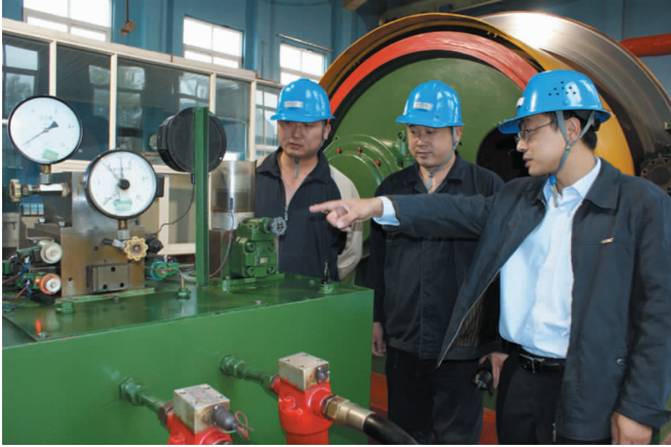
面对金融危机,丰山铜业公司积极向内挖潜,加大节能降耗工作力度,一方面紧缩成本开支,另一方面加强现场能源消耗管理,开展节电节油活动,最大限度地降低生产成本。图为 11 月 10 日上午,该公司采掘车间主要负责人在生产现场检查设备“无泄漏”情况。
